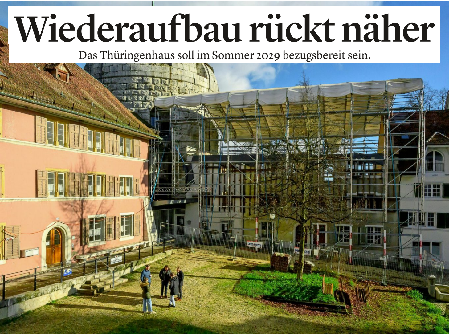
Noch ist der Riedholzplatz vom Brand von 2022 geprägt. Bis im Sommer 2029 soll der Wiederaufbau fertig sein. Archivbild: Bruno Kissling
