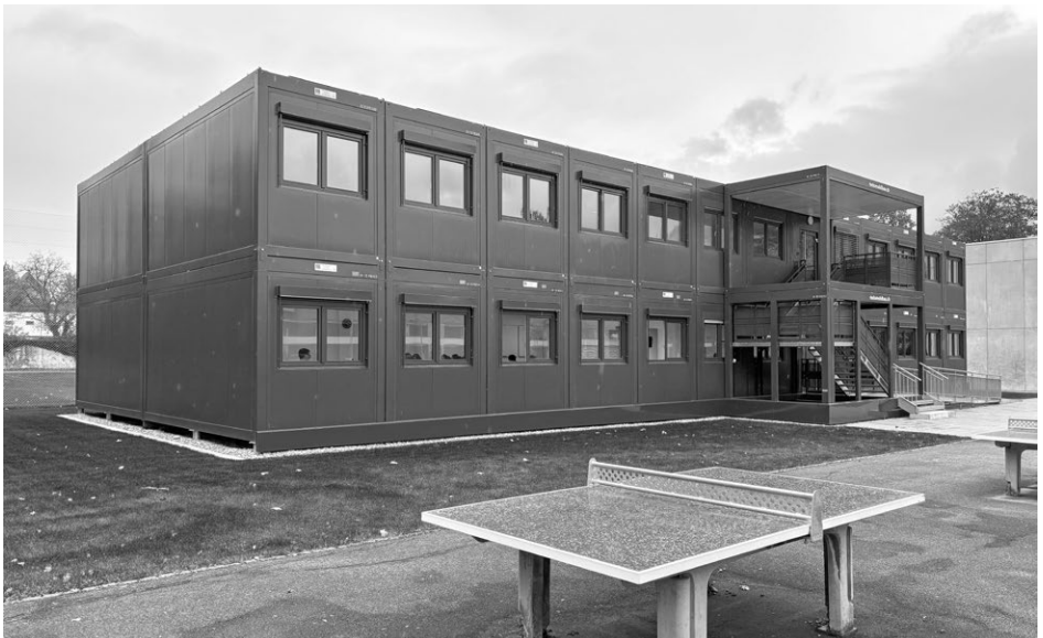
Schulraumprovisorium an der Sternengasse
